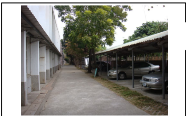
新棟教室後圍牆
